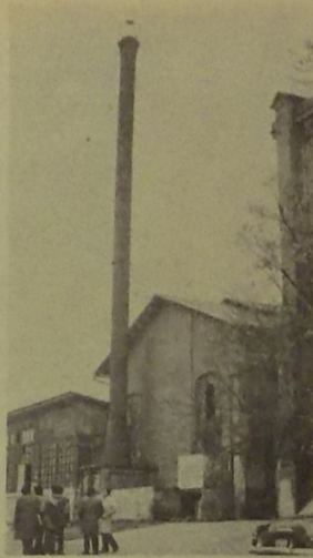
CHIMENEA PARA HORNO de fundición del siglo pasado.
